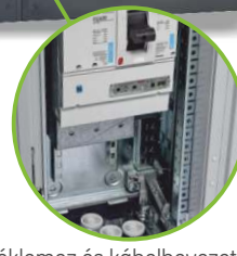
Feneklemez és kábelbevezetések
